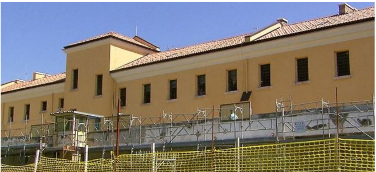
Das Gefängnis in Bozen, in dem zum Teil prekäre Verhältnisse herrschen, sollte längst schon durch einen Neubau in Bozen Süd ersetzt werden.
